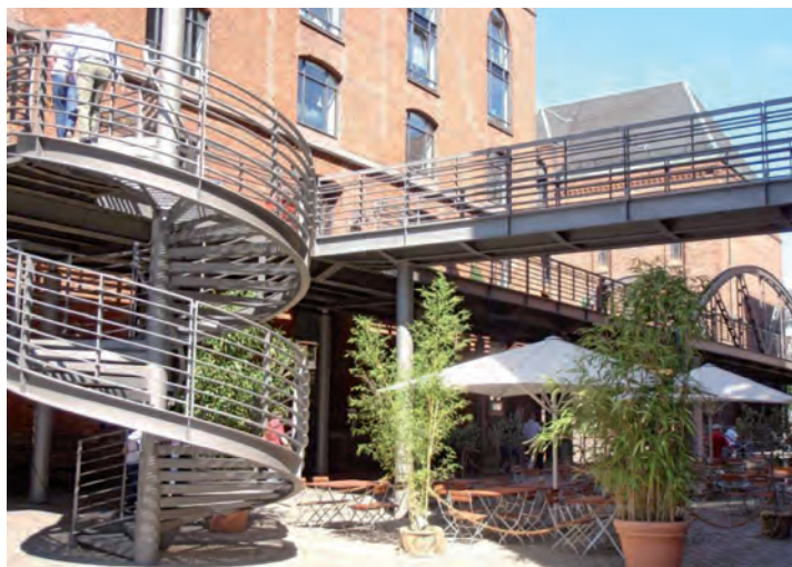
Passerelle piétonne à Rotterdam.
